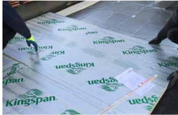
Darüber wurden PIR-Gefälledämmplatten verlegt Fotos: Kingspan Insulation
