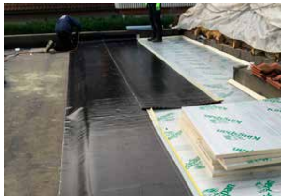
Als Abdichtung über den Gefälledämmplatten kamen Plastomerbitumenbahnen zum Einsatz
