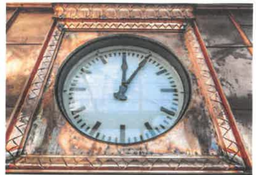
Bild: M. Rust/Dachwissen
