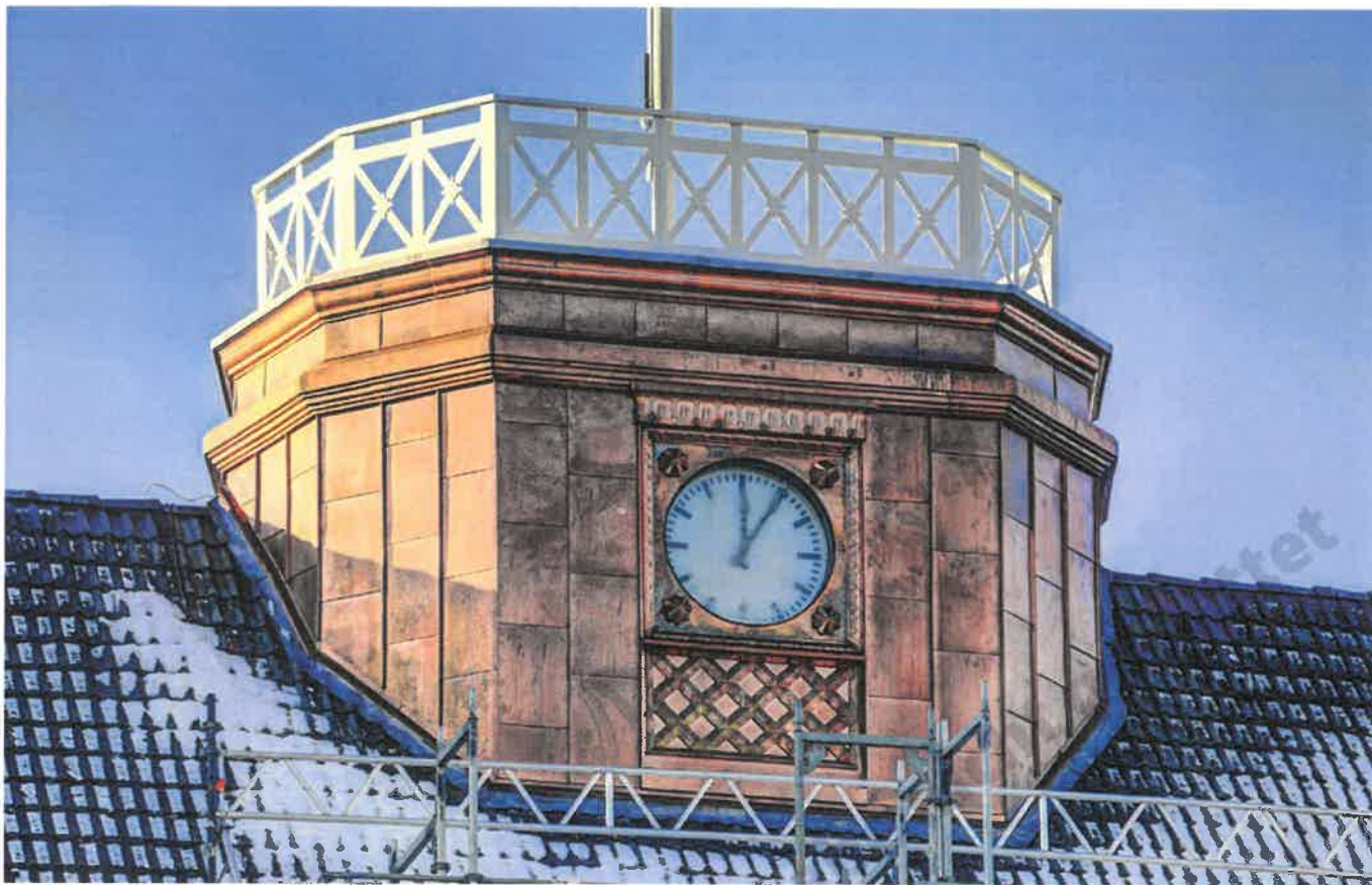
Bild: M. Rust/Dachwissen
