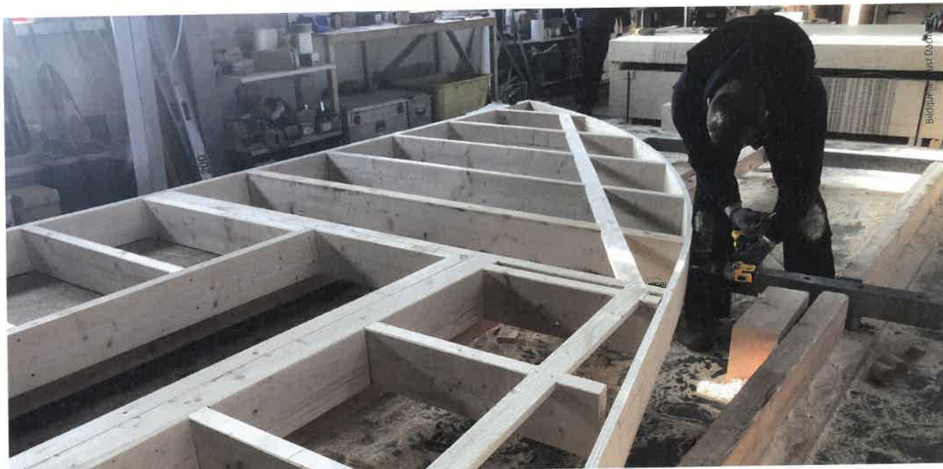
Nach einigen Abwägungen überzeugten die Vorteile eines Holzrahmenbaus in Verbindung mit einem Pfettendach.
