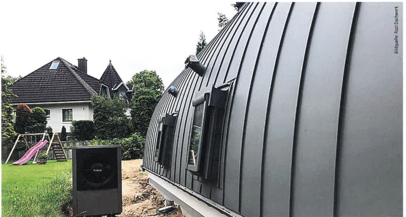
Der Einbau von vier Niedrigenergie-Dachfenstern in die gewölbte Dachfläche war klempnertechnisch und bauphysikalisch besonders anspruchsvoll. Die moderne Luft-Wasser-Wärmepumpe ist in der Lage, ein Haus bei Außentemperaturen bis -20 °C mit Wärmekomfort zu versorgen.
