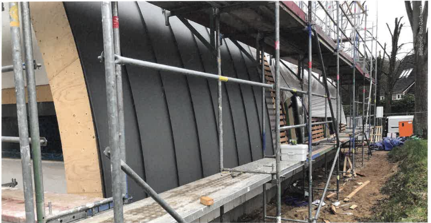
Alle Stehfalzscharen wurden in Eigenleistung gefertigt und nach Schablone in der Klempnerwerkstatt gerundet.
